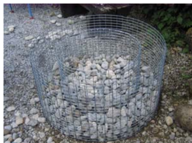
Abb. 1 Montage Innen- und Aussenkorb
